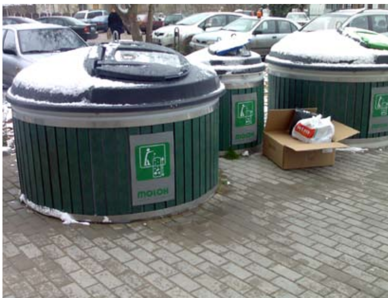
Bendrovė VSA propaguoja dar vieną atliekų tvarkymo būdą – požemines surinkimo sistemas „Molok“. Tai padidintos talpos konteineriai, kurių tik 40 proc. tūrio yra antžeminė konstrukcija, likusiose, kompanijos teigimu, atliekos susislegia labiau nei įprastose talpose, todėl jų telpa dvigubai.
